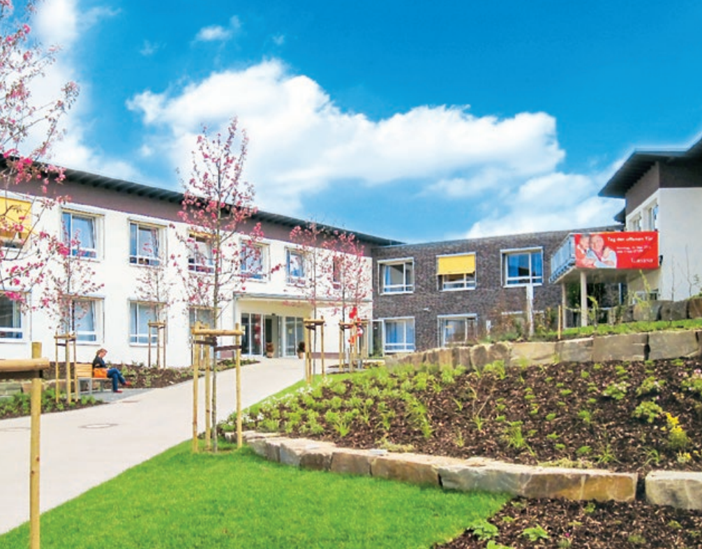
Geschäftiges Baustellentreiben, umsichtige Handwerker und zufriedene Einweihungs-Beteiligte mit Beistand „von oben“: das neue, strahlende Kursana Domizil in Kürten
